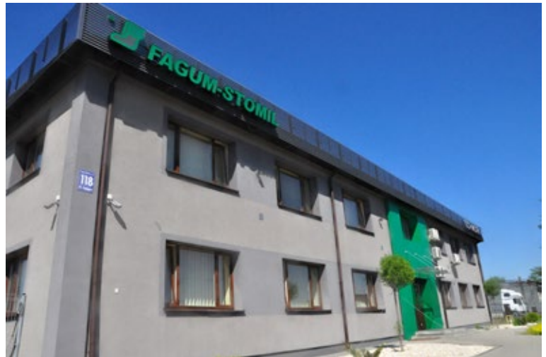
Bürogebäude in Łuków
